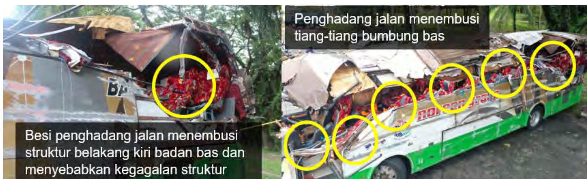
Gambar Rajah 22. Penghadang Jalan Menyebabkan Kegagalan Struktur Belakang Kiri Badan Bas dan Kegagalan pada Tiang-Tiang Bumbung Bas
