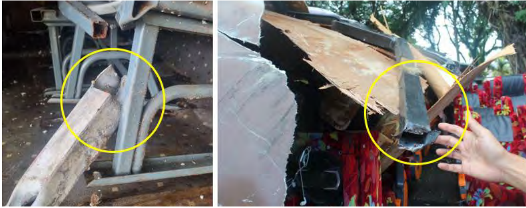
Gambar Rajah 23. Kesan Kegagalan Struktur Bas Disebabkan Tembusan Penghadang Jalan
