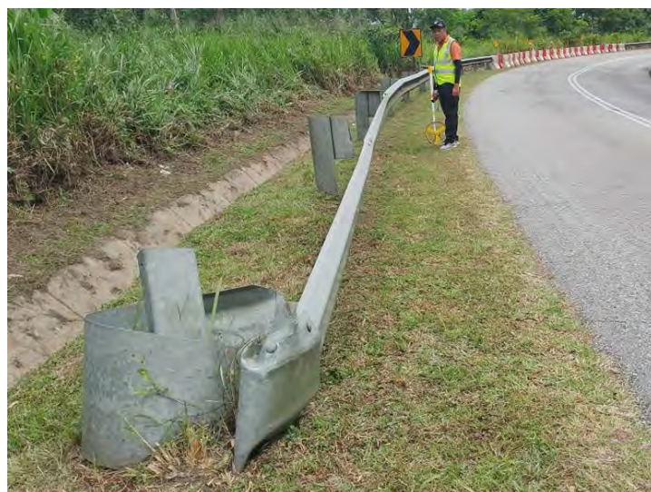
Gambar Rajah 8. Keadaan Hujung Penghadang Jalan (Terminal)
