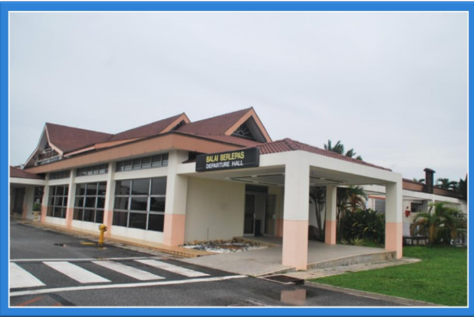
Gambar Sebelum kerja menaik taraf bangunan terminal (pandangan dari parkir pesawat) LTSAS Ipoh
