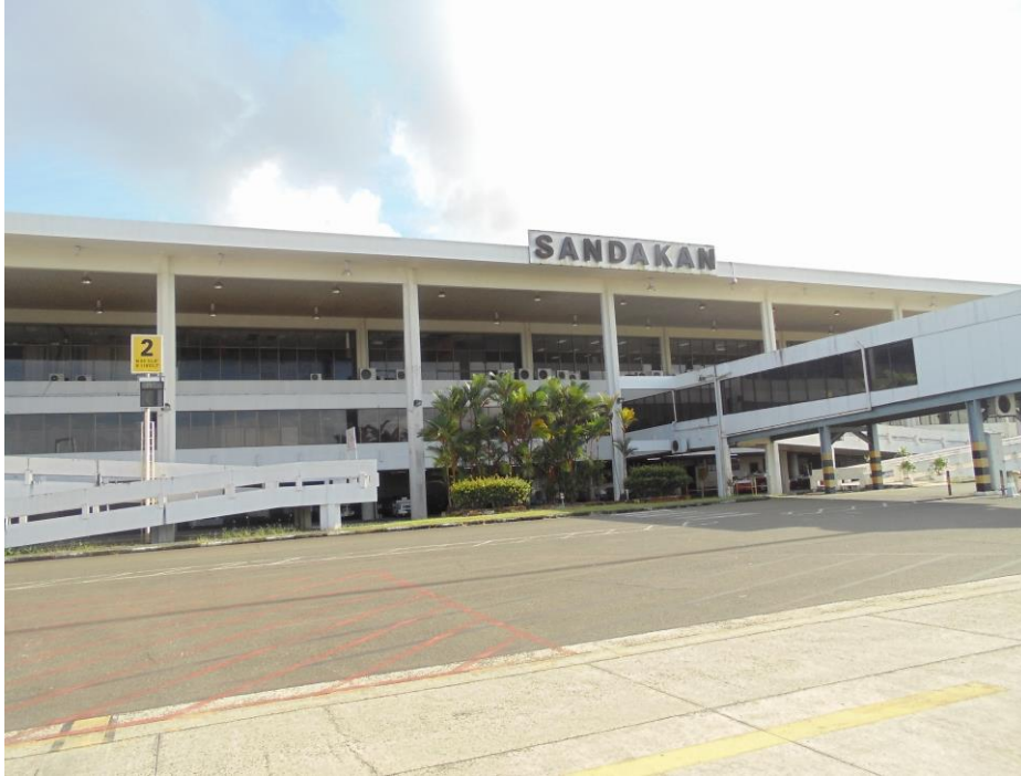
Bangunan Terminal – Sebelum
