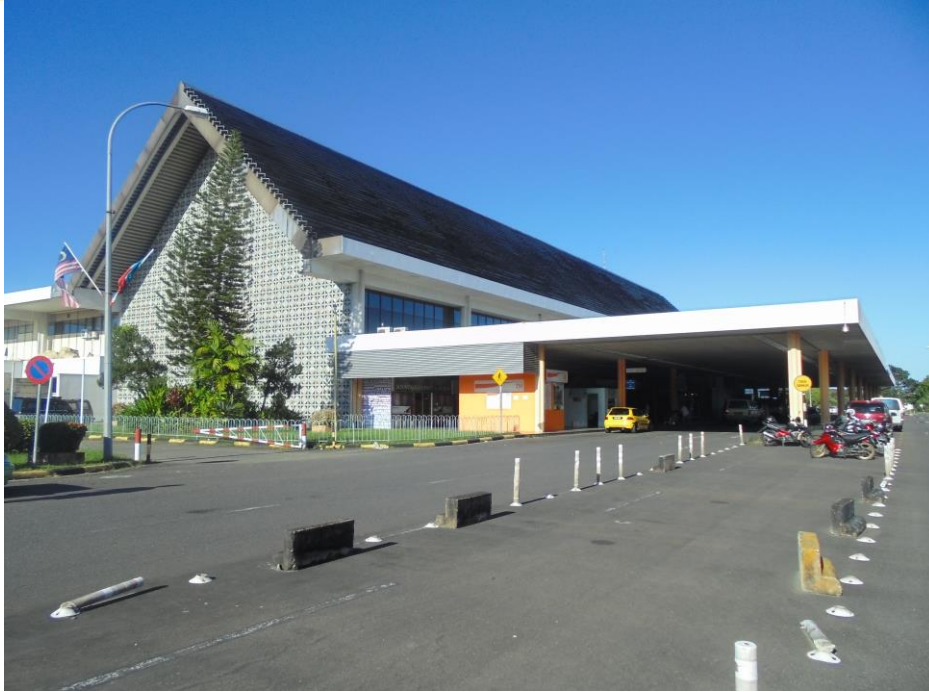
Bangunan Terminal – Sebelum
